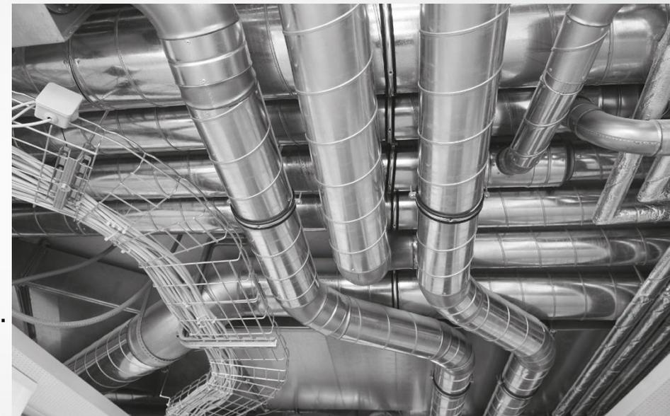
Для транспортировки воздуха с повышенной влажностью, температурой и с содержанием химически агрессивных соединений, мы производим воздуховоды **из нержавеющей стали или титана. Нержавеющая сталь** используется при транспортировке воздуха с температурой до 500 С.
